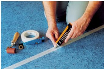
Примерно через 10 минут, когда средство для холодной сварки на поверхности скотча высохнет, снимите скотч, потянув его под острым углом назад.
