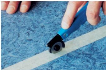
В случае, если напольное ПВХ-покрытие не достаточно эластичное (например, полу коммерческое напольное ПВХ-покрытие), рекомендуется нагреть область шва феном или утюгом (не более 40 °C). Это позволит легко и равномерно вести иглу.
